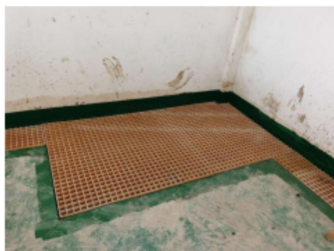
老危废间收集沟、收集池
