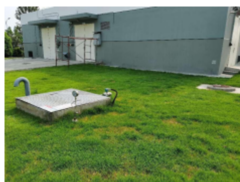
危险品库、新危废间收集池
